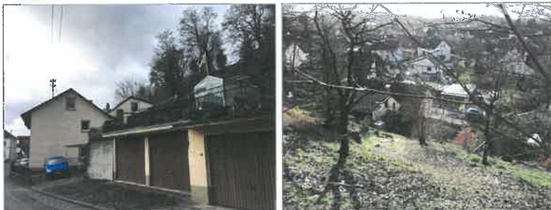
Abbildung 9: Teilfläche 6 mit Bebauung (links) und Garten am Oberhang (rechts) (Fotos: HPC AG, 02.01.2019)
