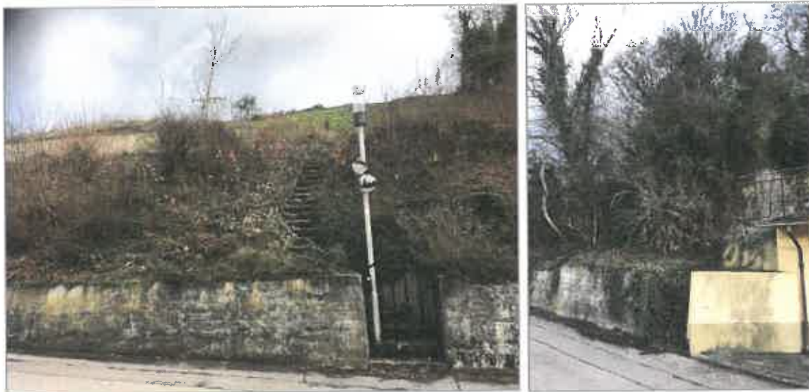
Abbildung 8: Teilfläche 5; im Norden Sträucher/Grünland (links), im Süden Baum-/Strauchbestand (rechts) (Fotos: HPC AG, 02.01.2019)
