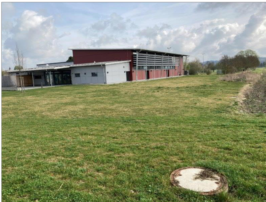
Abb. 5: Blick aus der Südwestecke der Vorhabenfläche nach Nordosten. Im Hintergrund liegt die Mehrzweckhalle. (Foto: HPC AG, 31.03.2022)
